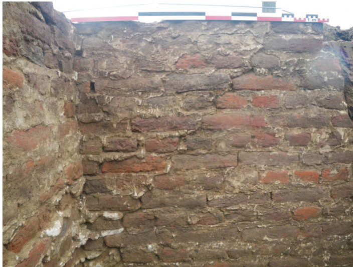
Fig. 5.12: Opbouw van het muurwerk.
