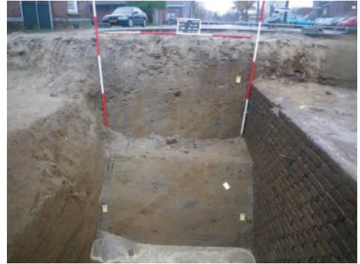
Fig. 5.7: Kijkgat met grachtvulling tegen de schildmuur van de vesting St. Michiel aan.
