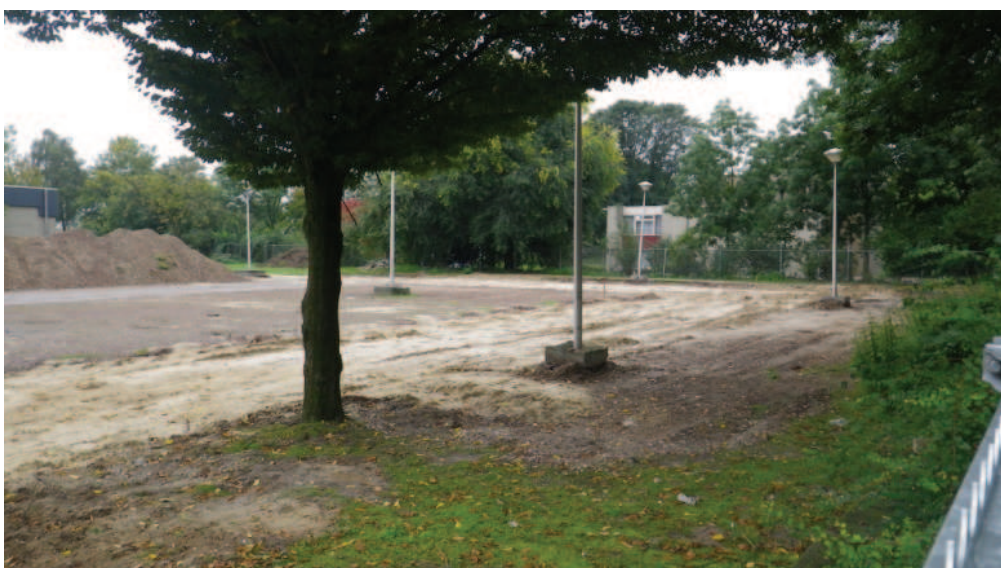
Fig. 0.1: De locatie schoolplein voor het begin van het proefsleuvenonderzoek.
