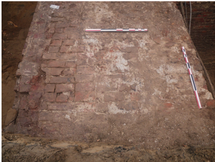
Fig. 5.13: Bovenzijde van het muurwerk, met links de 19 e -eeuwse klampmuur, rechts daarnaast een verdikking uit ca.1810 en rechts het oorspronkelijke 17 e -eeuwse muurwerk.
