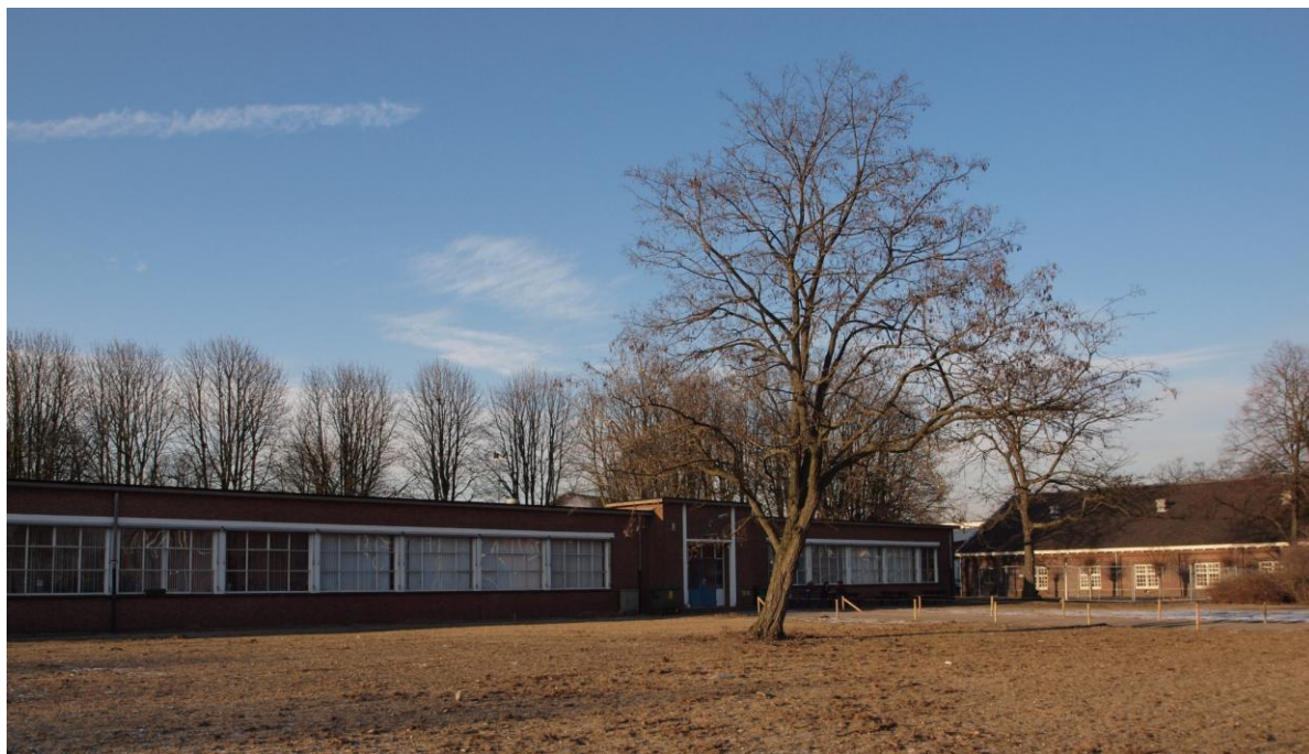
Figuur 45 Gebouw U
