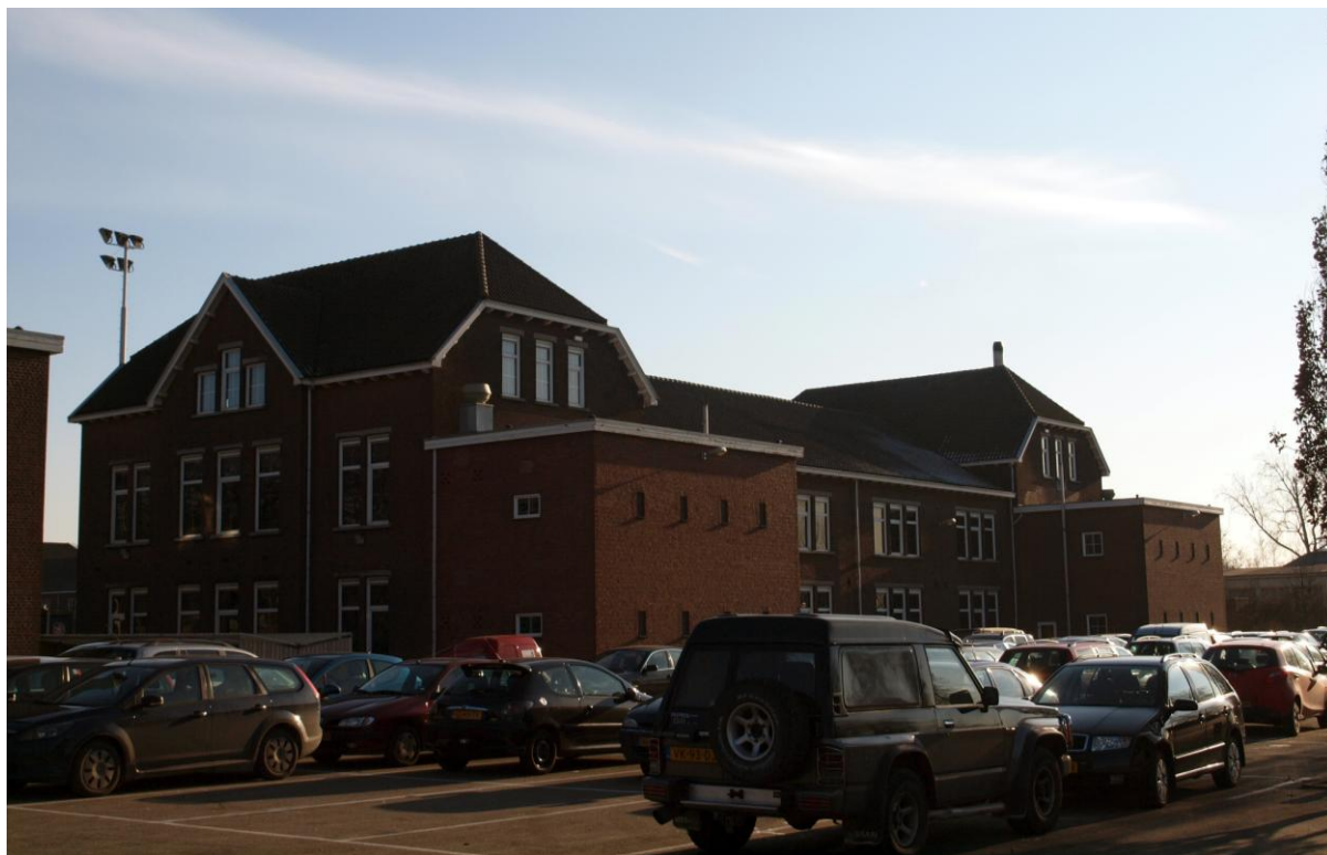
Figuur 31 Gebouw E
