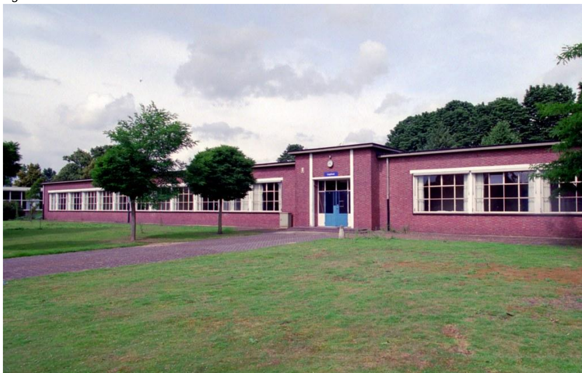
Figuur 46 Entree gebouw U
