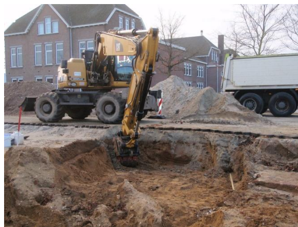
Foto 4: Start sanering ter plaatse van boring 7.
