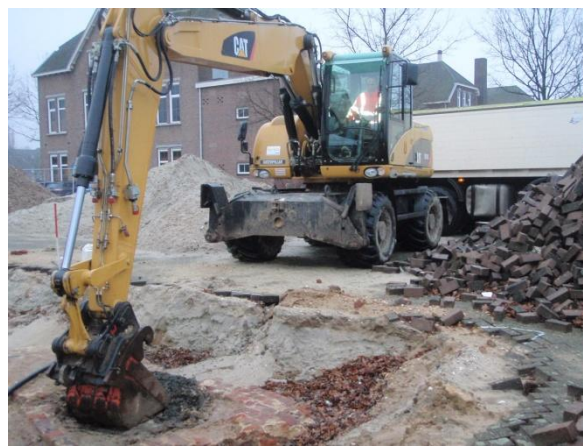
Foto 2: Start sanering ter plaatse van boring 8.
