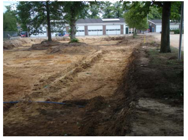
Foto 4: Er is gegraven tot op de ongeroerde grond.
