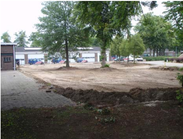
Foto 1: De eerste 30 cm zijn ontgraven.
