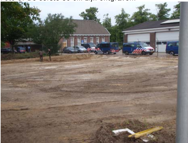
Foto 5: De eerste 30 cm zijn ontgraven.
