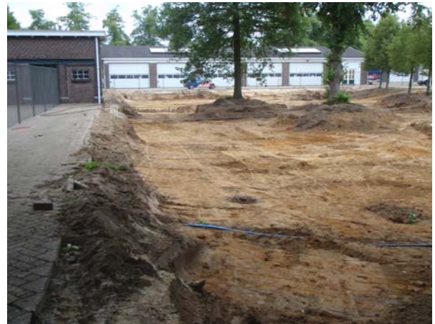
Foto 2: Er is gegraven tot op de ongeroerde grond.
