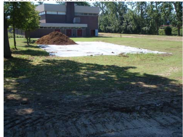
Foto 16: Depot in oprichting t.p.v. gebouw O
