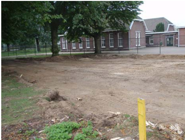
Foto 9: De eerste 30 cm zijn ontgraven.
