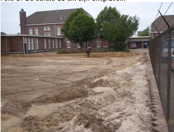
Foto 7: De eerste 30 cm zijn ontgraven.
