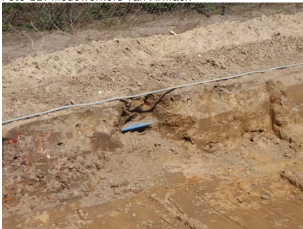
Foto 13: Bestaande kabels en leidingen
