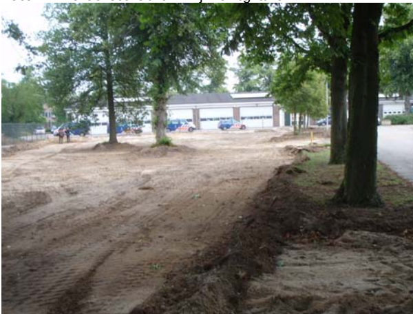
Foto 3: De eerste 30 cm zijn ontgraven.
