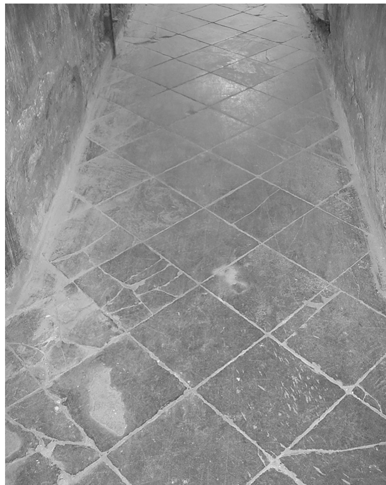
Overzicht van de vloer in de gang, bestaande uit overhoeks geplaatste hardsteentegels
