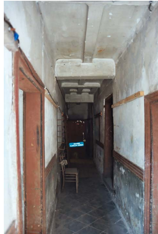
Afbeelding 14 Centrale gang hoofdgebouw
