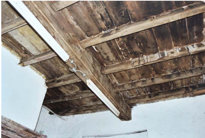
Afbeelding 17 Balklaag in keuken hoofdgebouw
