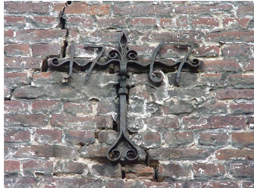
Afbeelding 4 Jaaranker voorgevel
