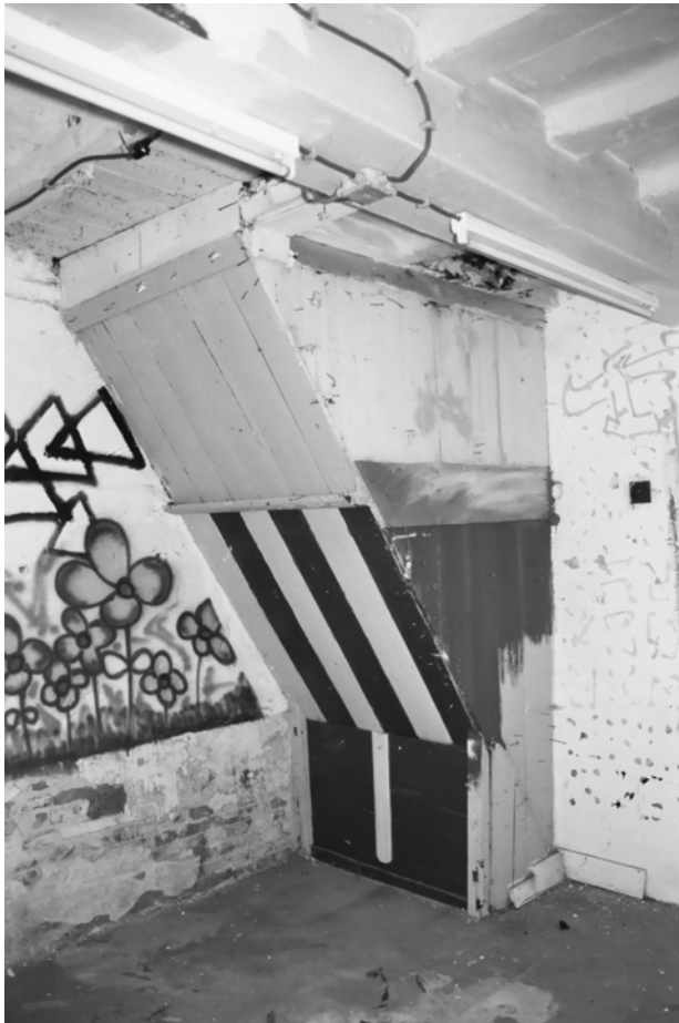
Afbeelding 25 Omkasting trap in middenkamer
