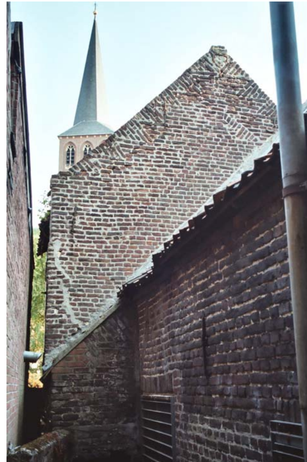
Afbeelding 48 Bouwsporen ophoging voorgebouw
