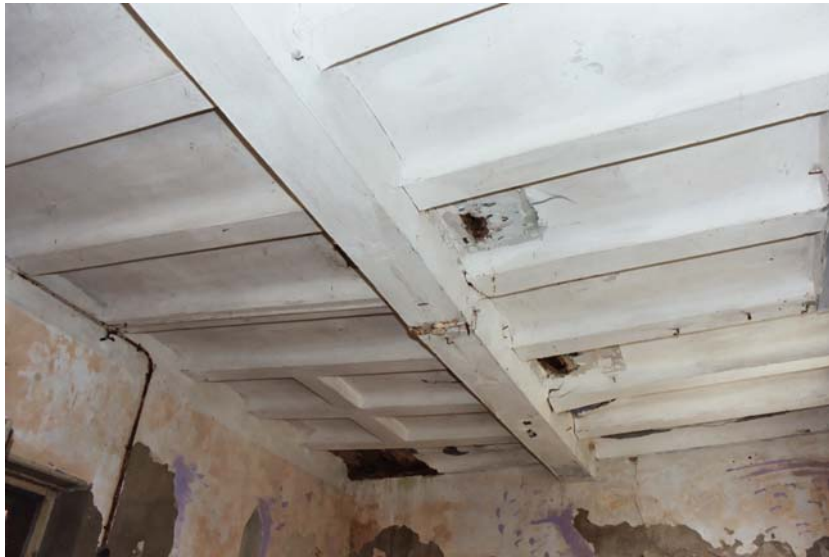
Afbeelding 49 Balklaag met moerbalk en kinderbinten voorgebouw
