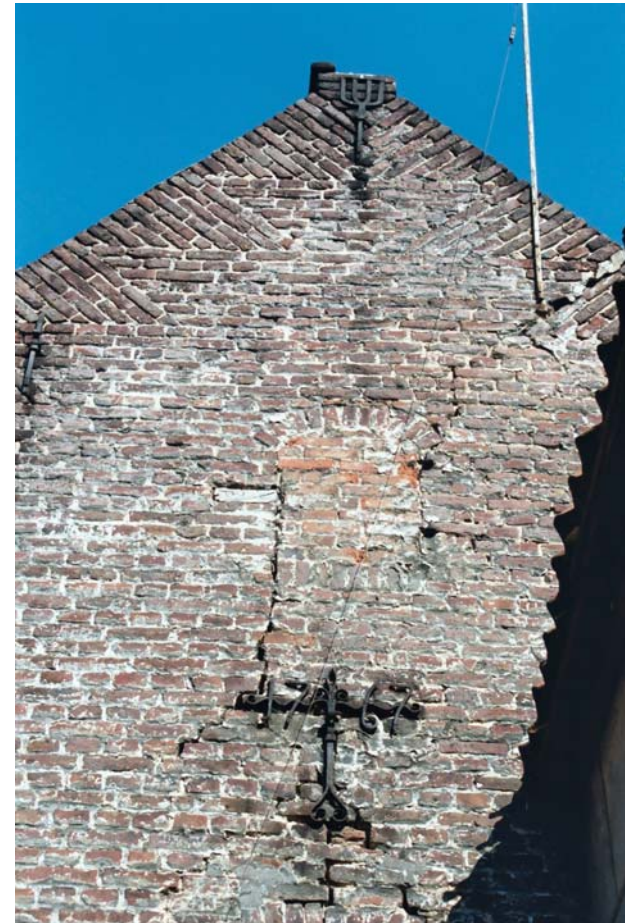
Afbeelding 2 Detail voorgevel hoofdgebouw
