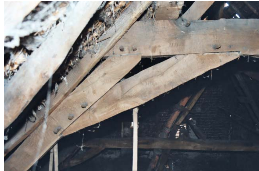
Afbeelding 34 Telmerken kaspant hoofdgebouw
