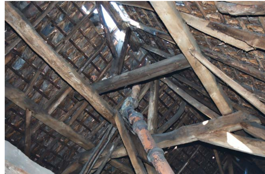
Afbeelding 38 hulpconstructie rookkanaal
