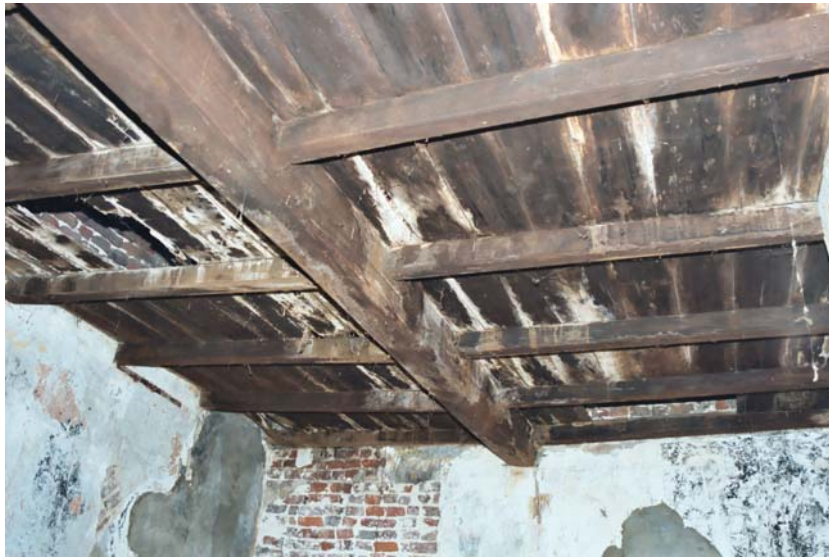
Afbeelding 53 Balklaag verdieping voorgebouw
