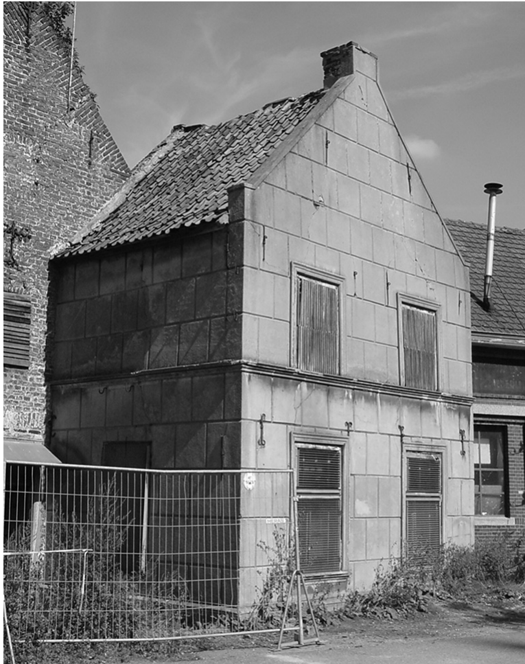
Overhoeks aanzicht van het voorgebouw: linkerzijgevel en voorgevel.
