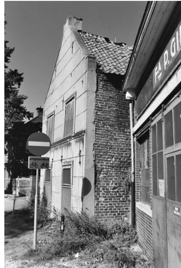
Afbeelding 46 Blinde rechterzijgevel voorgebouw
