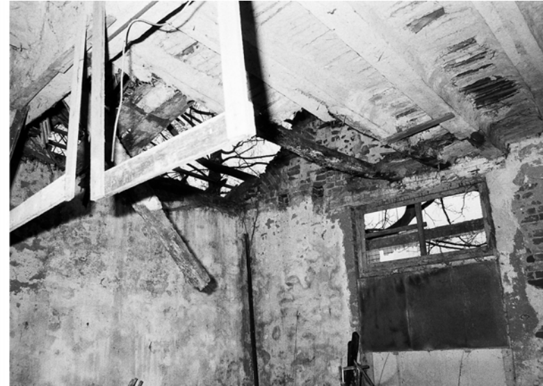
Afbeelding 68 Balklaag achterbouw vóór de instorting in juli 2002
