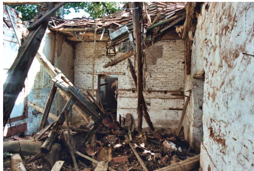
Afbeelding 64 Bewaard gebleven moerbalk van zoldering souterrain
