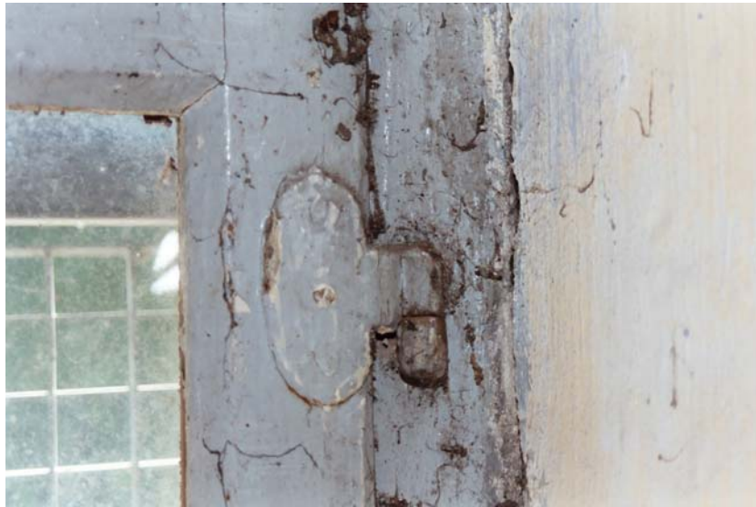
Afbeelding 43 scharnier stolpraam voorggebouw
