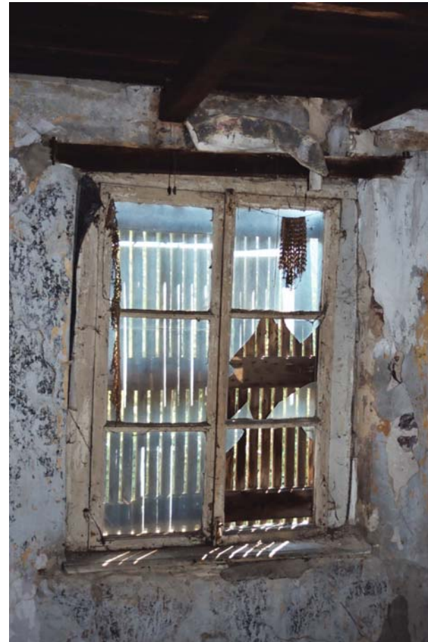
Afbeelding 44 Stolpraam verdieping voorgebouw
