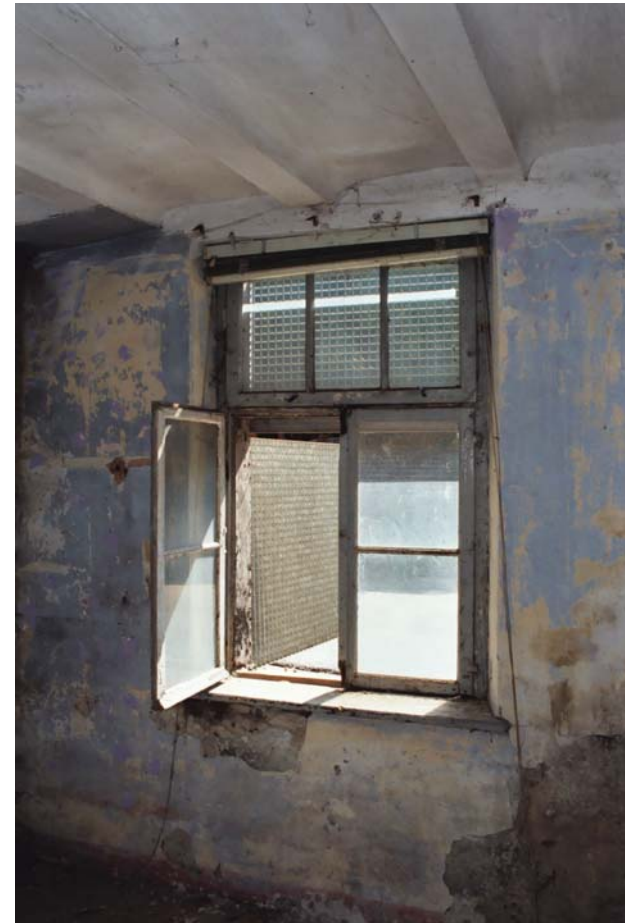
Afbeelding 42 Venster voorgevel voorgebouw
