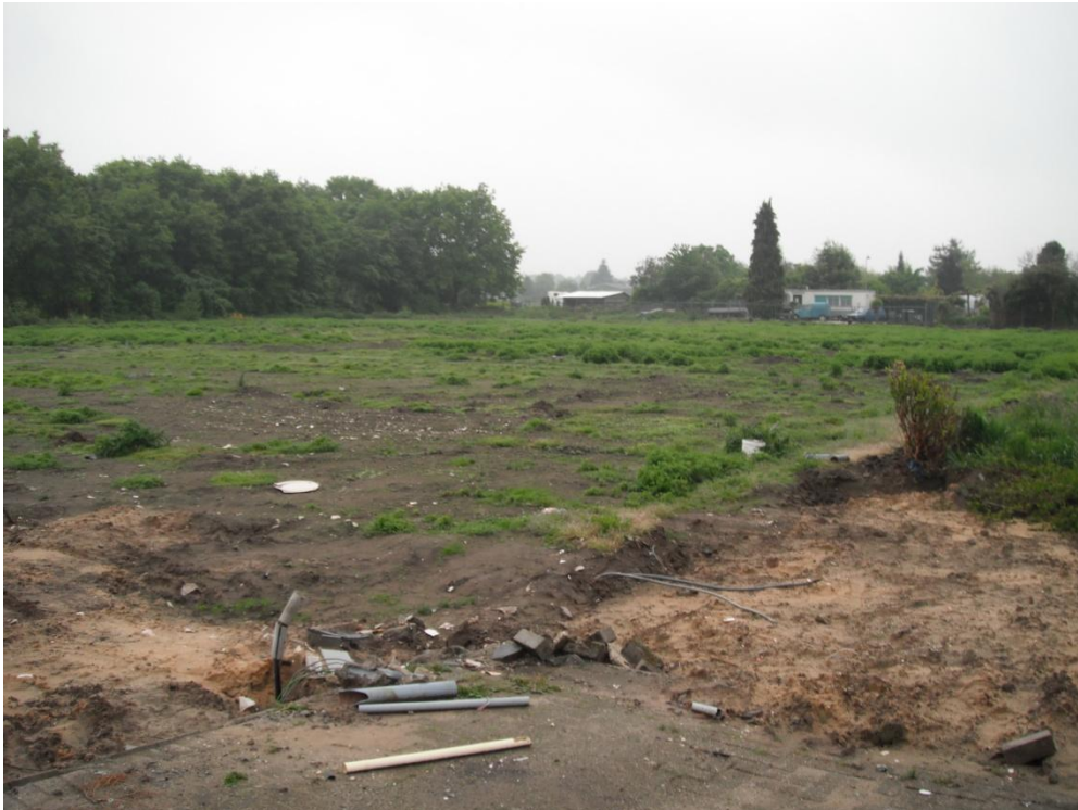
Figuur 4. Foto's van het plangebied na de sloop van de tuinkas
