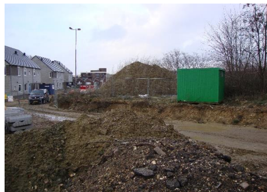
Zicht op zuidzijde plangebied (gronddepot)
