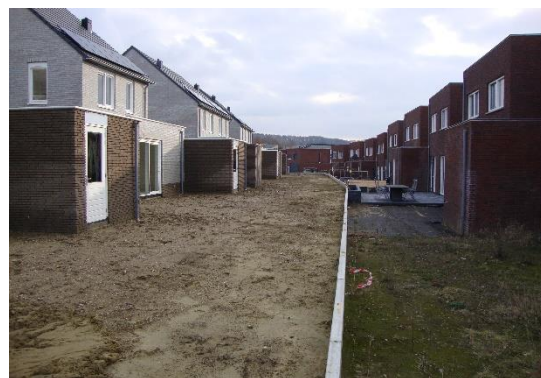
Woningen in aanbouw (achterzijde Groenzandweg)
