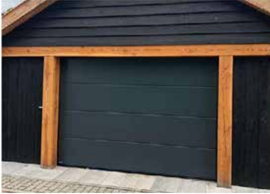
Poort in kleur van de gevel
