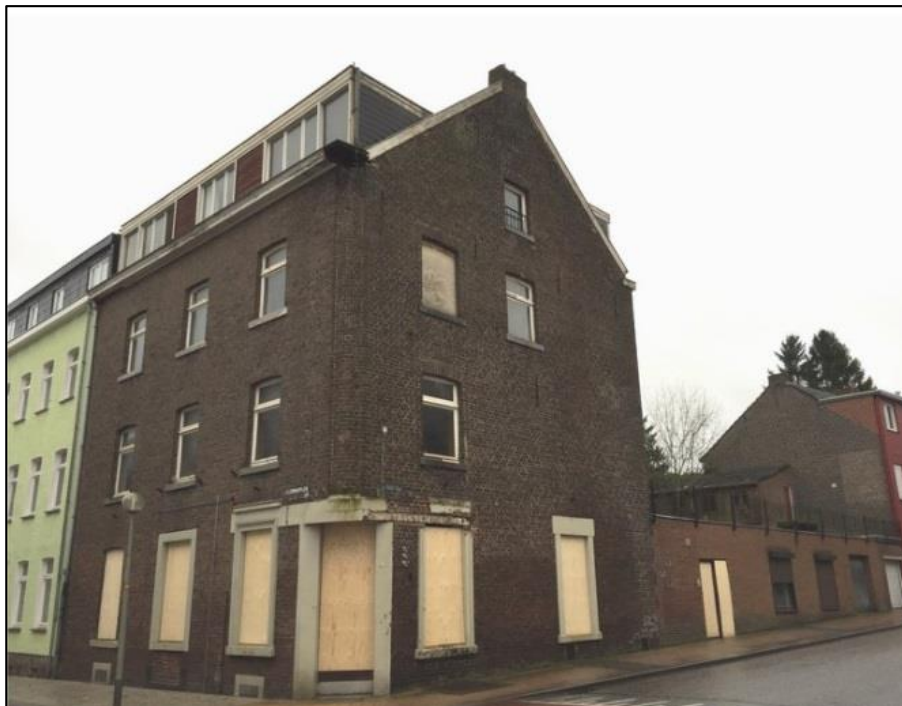
Foto bestaande situatie
