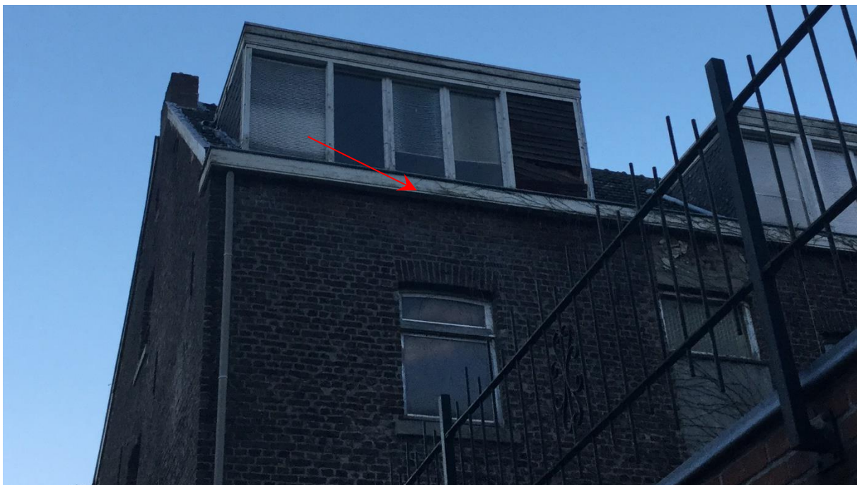
Figuur 3.3 Locatie van de twee nesten gierzwaluw onder de dakrand onder de dakkapel (bij de rode pijl).
