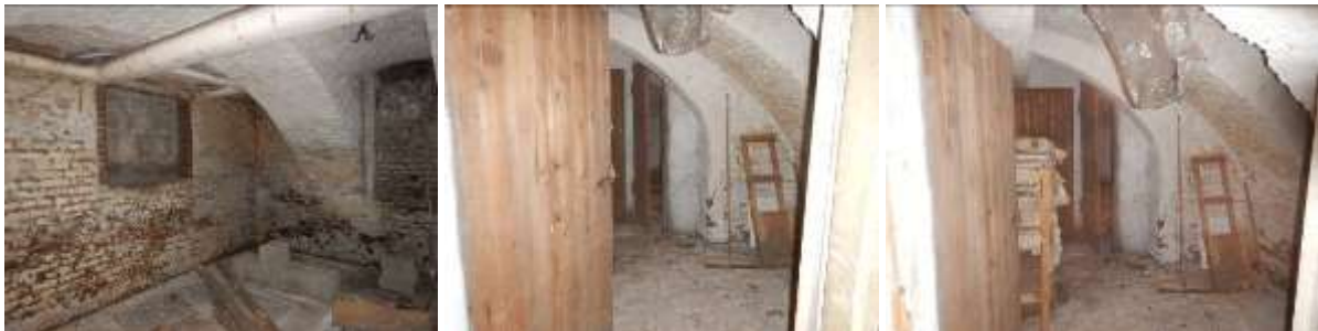
Figuur 16: De gewelfde kelder onder de voorzijde het huidige pand. 16
