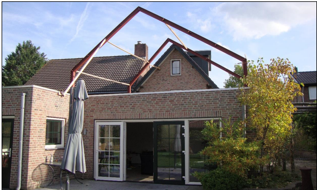
Achtergevel woning Rott 53
