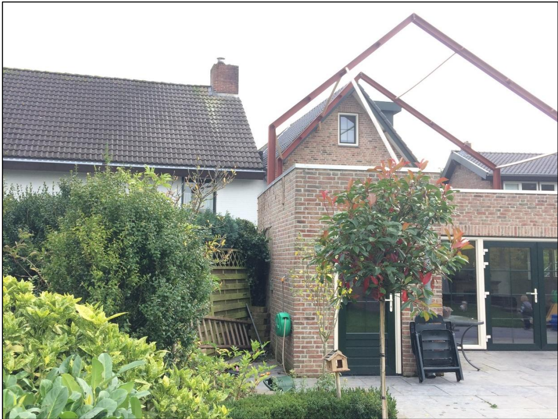
Achtergevels woningen Rott 51 en 53 (2)
