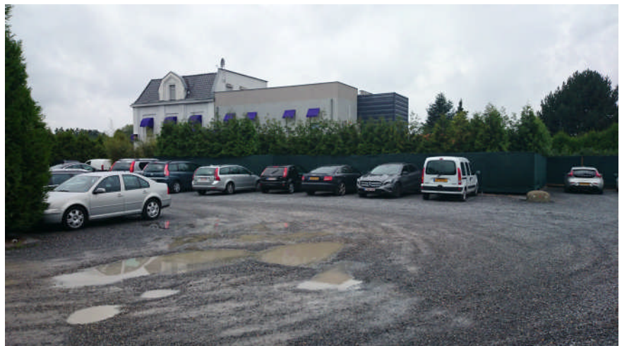
Zijgevel; deels aan het zicht te onttrekken met wegbegeleidende bomenrij
