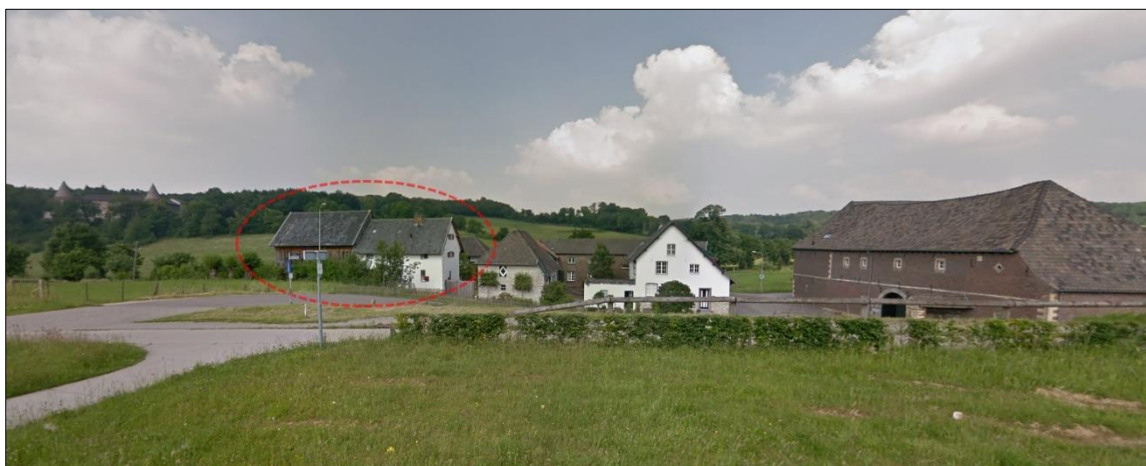
Foto bestaande situatie (Bron: Google Streetview vanaf de Rijksweg)
