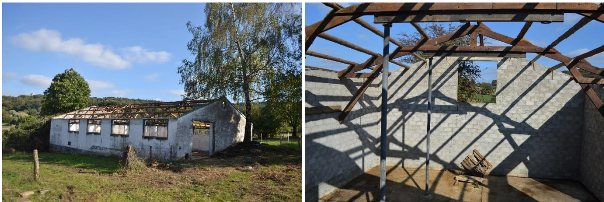
Figuur 1.5: Links koestal 3 (nr. 6.) die wordt verbouwd tot atelier. Rechts koestal 1 (nr. 3) welke wordt verbouwd tot woning waarbij de achterwand zichtbaar op de foto eruit wordt gesloopt.
