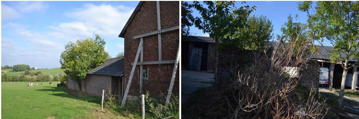
Figuur 1.4: Links de werktuigenloods (nr. 2) aan de noordzijde en rechts de loods aan de zuidzijde. Aan deze loods vinden alleen in pandig werkzaamheden plaats.
