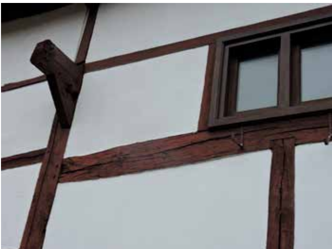
3. Een van de functieloze uitkragenschoren, met daaronder de bovenbalk van de dichtgezette poort van het oorspronkelijke complex, in fase 2
