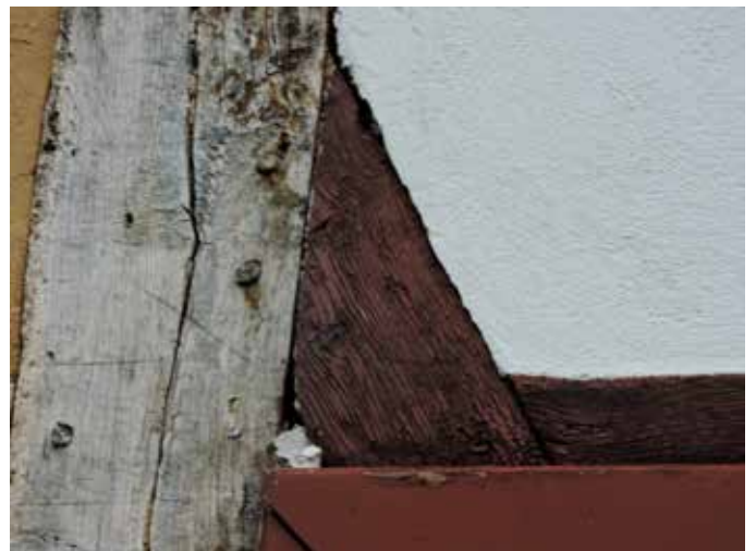
4. Tegen de belending, boven de moderne poort, is nog net een deel van een afgezaagde schoor te zien uit de oorspronkelijke constructie
