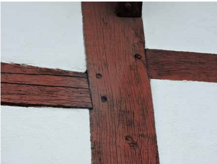
7. Oorspronkelijke poortbalk en getoogde regel van de oorspronkelijke schuur
