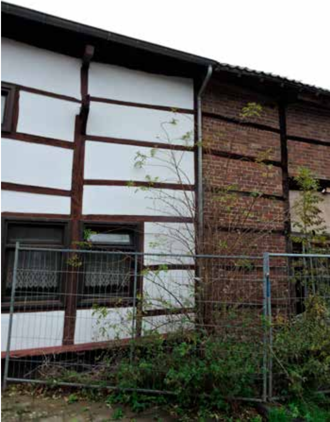
5. Het linker travée van de latere schuur is nu deel van het woonhuis
