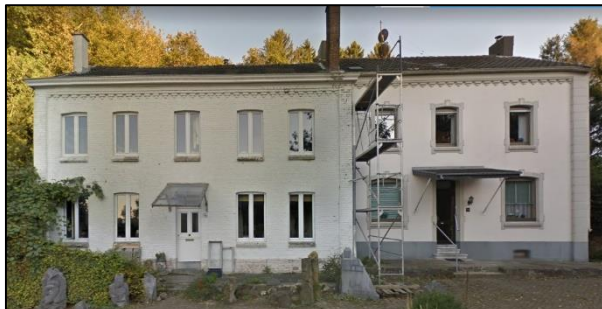
Foto bestaande situatie Gemmenicherweg 56 (links) en 58 (rechts)
