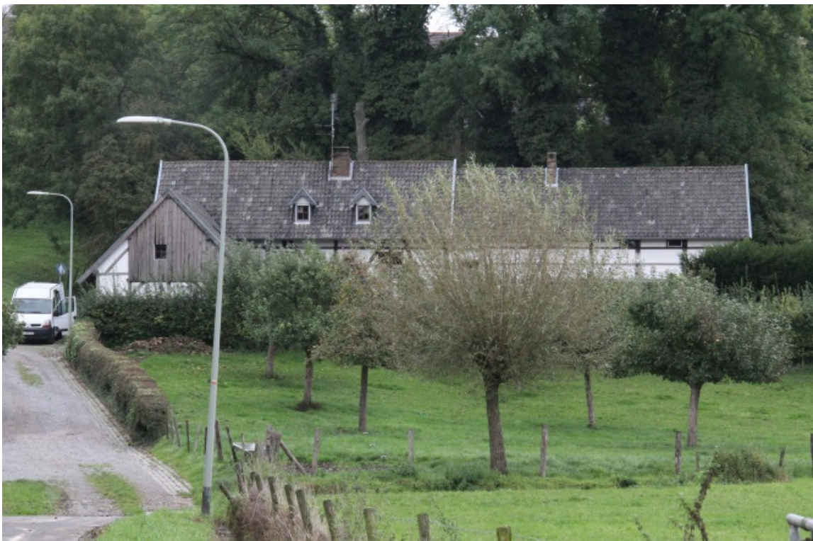
Overzicht van de zuidgevel
