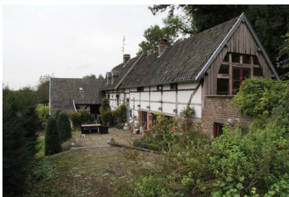
Het gebouw gezien vanuit het zuidoosten. Het voormalige schuurgedeelte aan de oostzijde is weliswaar op traditionele ambachtelijke wijze herbouwd, maar heeft alleen v.w.b. de contour een relatie met de oorspronkelijke bebouwing.
