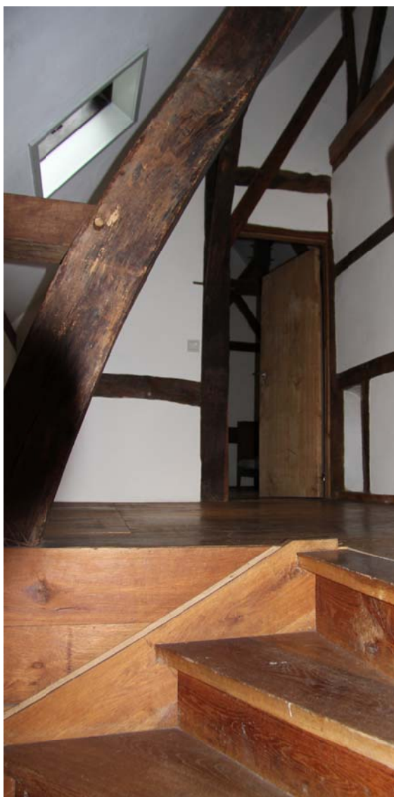
Ook inwendig zijn is vakwerk als kamerscheidende wanden toegepast
