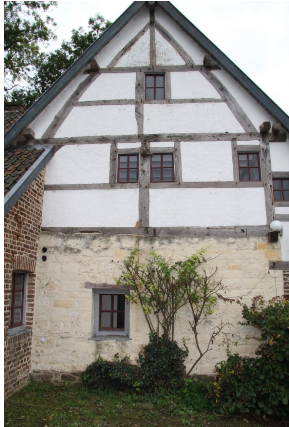
De huidige gerestaureerde voorgevel
