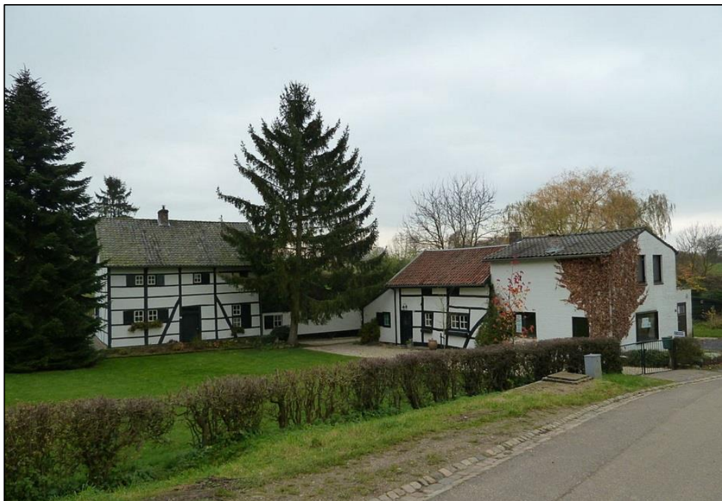
Foto bestaande situatie. De vakwerkwoning met rode dakpannen betreft huisnummer 48a. De woning aan de wegzijde betreft huisnummer 50.
