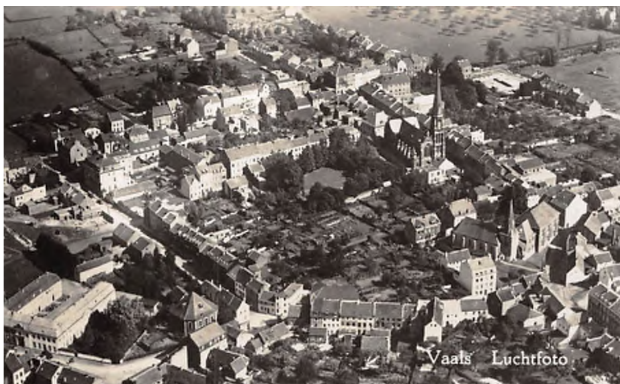
Afbeelding 12: Luchtfoto Vaals uit 1951. Bron: House-of-cards.nl
