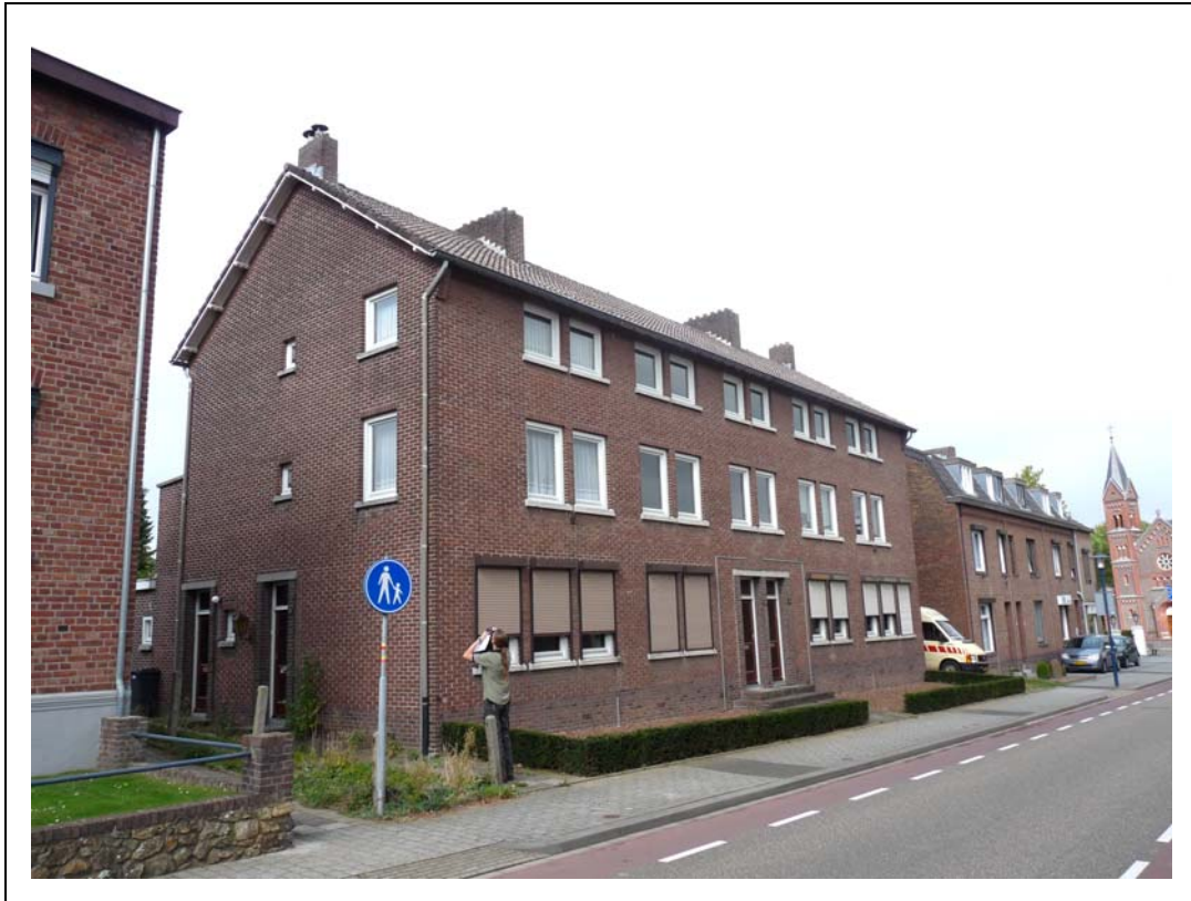
Foto 1. voorzijde te slopen appartementengebouw
