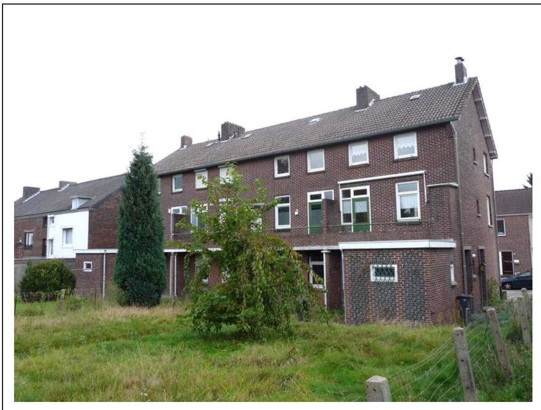
Foto 2. achterzijde te slopen appartementengebouw
