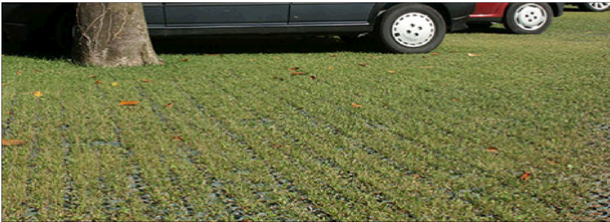
open verharding met duidelijk patroon tbv. aanduiding parkeerplaats, bijvoorbeeld kunststof infiltratieroosters / gazonbeschermingsnet met gras of mos
