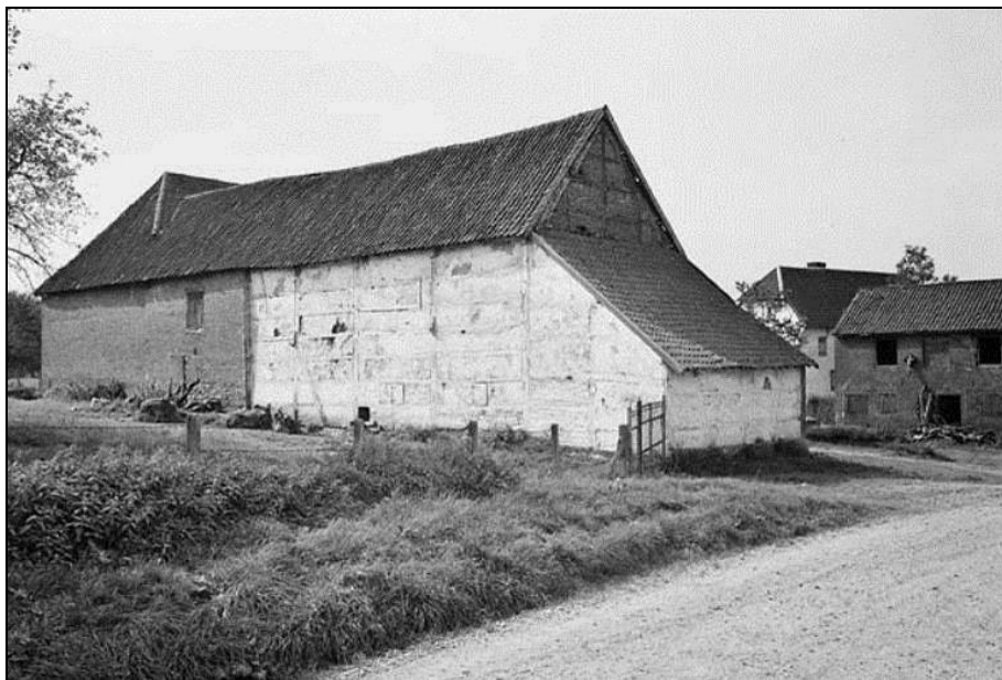
Figuur 24: Oostgevel van het bijgebouw in 1958 (bron: archief RCE)
