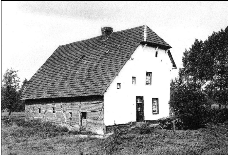
Figuur 22: De zuid- en oostgevel van het hoofdgebouw in 1957 (bron: archief RCE)
