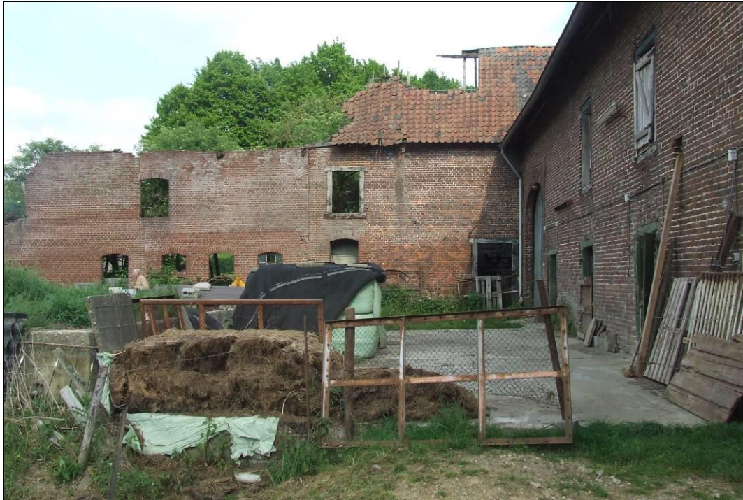
Figuur 29: foto van de L-vormige schuur me binnenplaats. Deze binnenplaats ligt Ruim een halve meter hoger dan het perceel rondom het hoofdgebouw.
