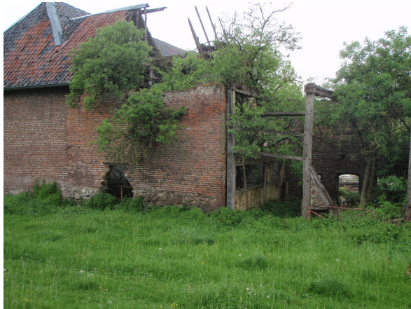
Foto 9: locatie ligging oude tank.
