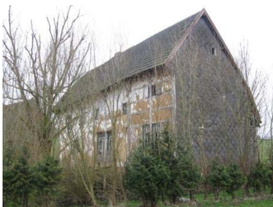
Figuur 3: Het vervallen voormalige woonhuis.
