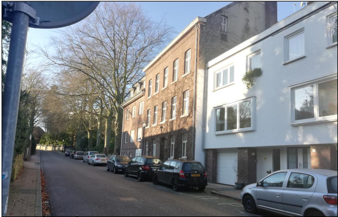
De woningen aan de Bosstraat 59 t/m 63
