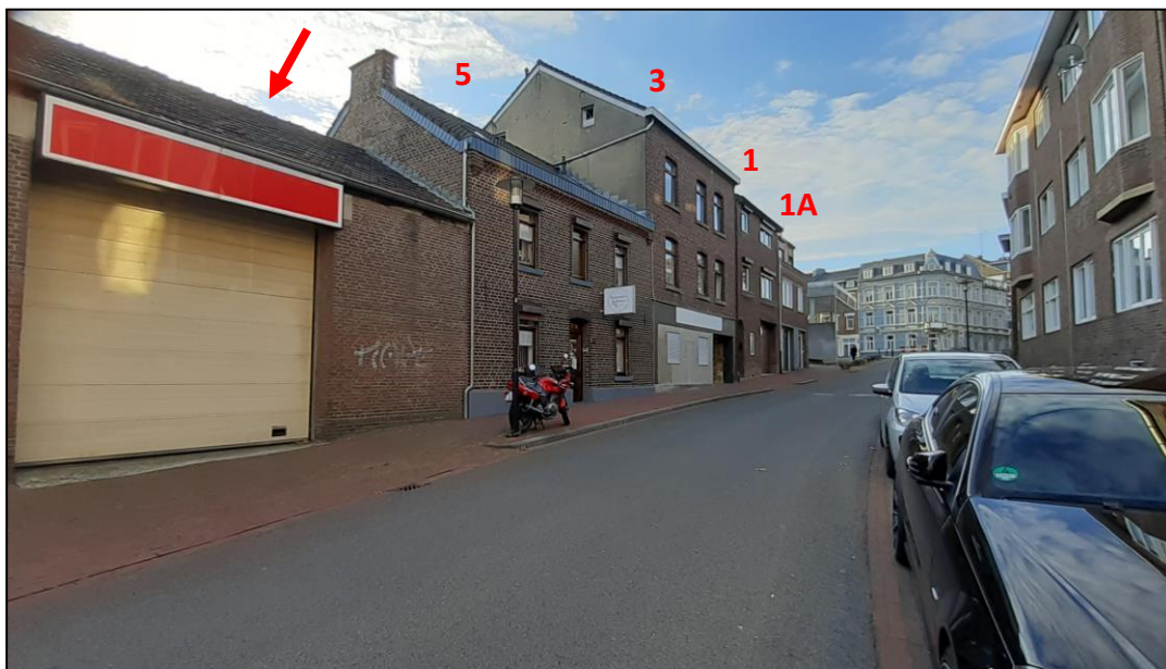
De woningen aan de Jos Francotteweg 1A, 1, 3 en 5 en de te slopen garagebox
