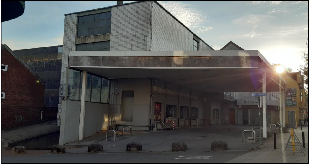
Voor- en linkerzijgevel bebouwing vml. tankstation Maastrichterlaan/Jos Francotteweg
