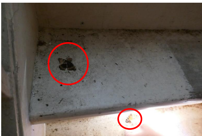
Vraatrestanten van grootoorvleermuizen. Op meerdere plekken in het gebouw aangetroffen
