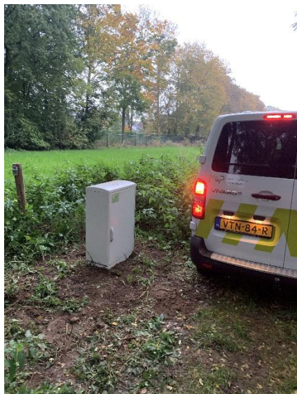
figuur 2 Meetopstelling bij Spoorweglaan Urmond
