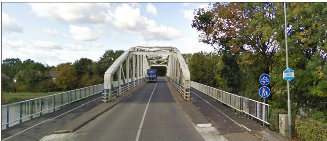
brug 'Urmond' met aan weerszijde een fietspad gescheiden van de rijbaan
