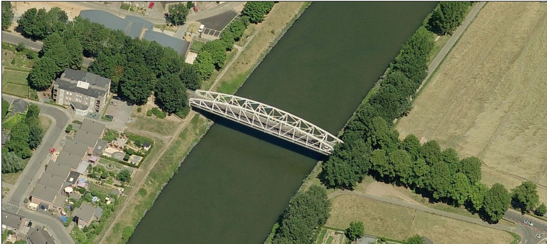
luchtfoto van de te verbreden brug
