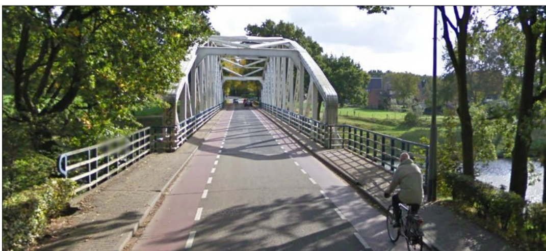
brug 'Berg' met de fietspaden binnen hetzelfde wegvlak
