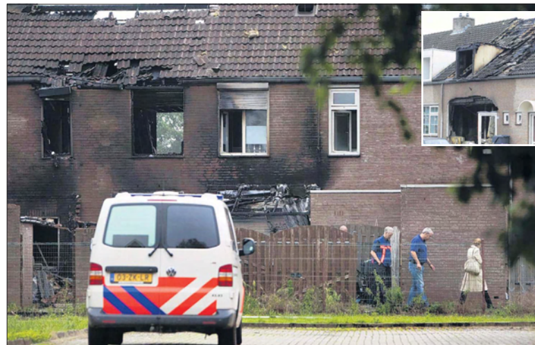
Door de kracht van de explosie werden de achter- en voorgevel (inzet) zwaar beschadigd.
