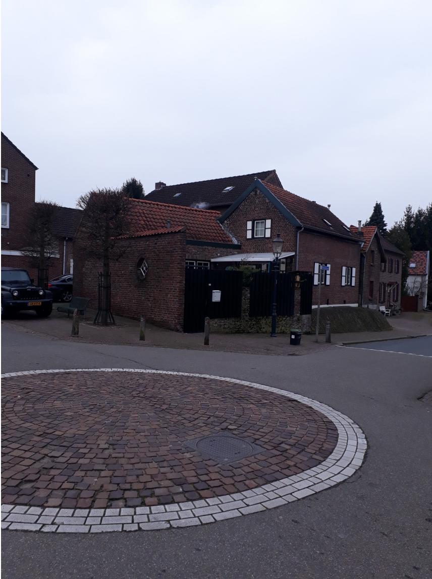
Fig. 2.4 Bestaand hoekpand Kelderstraat/Kruisstraat.
