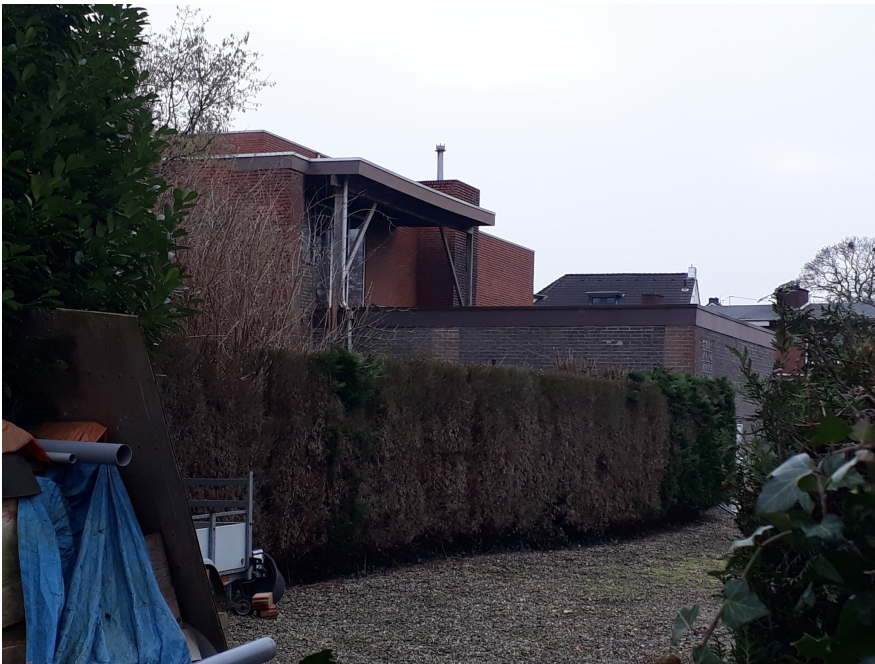
Fig. 2.3 Bestaande achterbebouwing nabij Kruisstraat 43; in dezelfde zone is 2 en 1 laags aangebouwd.
