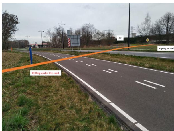
Figuur 2.10: onderdoorgang Nieuwe Postbaan
