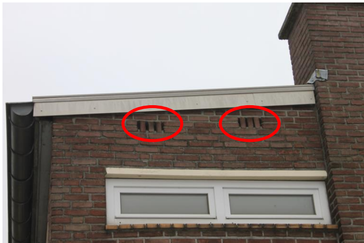
Foto 2: openingen die ruimte bieden voor vleermuizen als vaste rust- en verblijfplaats
