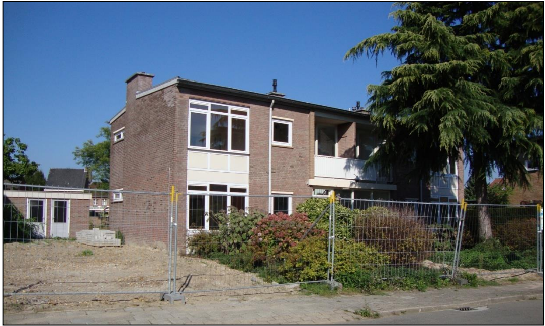
De voorgevel van één van de drie bouwblokken, die thans binnen de projectlocatie aanwezig zijn
