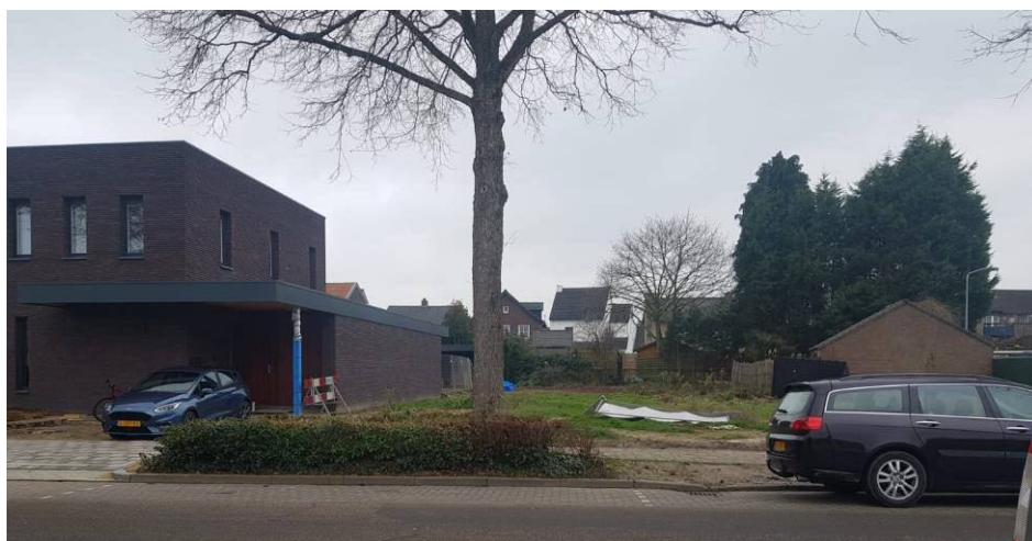
Figuur 4: Zicht op projectlocatie en naastgelegen perceel (huisnummer 4) vanaf de Michiel de Ruyterstraat (bron: Google Maps)
