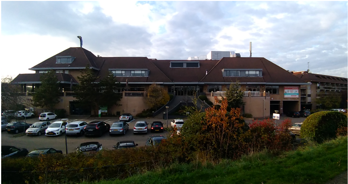
(Beperkte) zichtbaarheid luchtbehandelingskast vanaf fietspad
