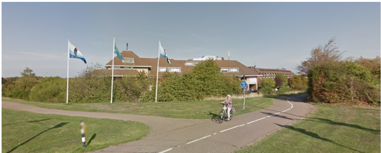
(Beperkte) zichtbaarheid luchtbehandelingskast vanaf hoek Mauritslaan/Nieuwe Postbaan.
