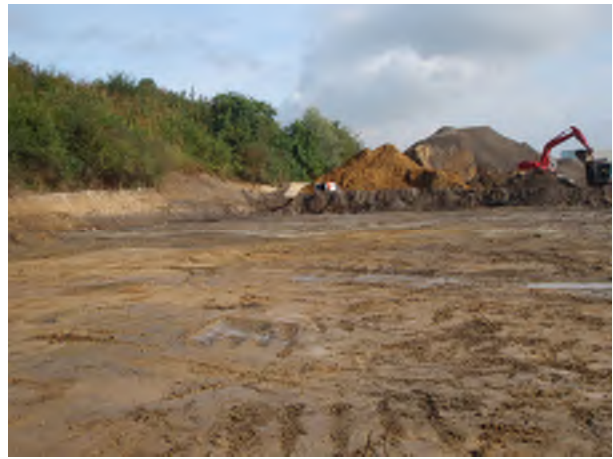
Foto 4: In de achtergrond wordt bij boring 10 het laatste deel van de \pm 1 meter hoge granulaatlaag verwijderd.
