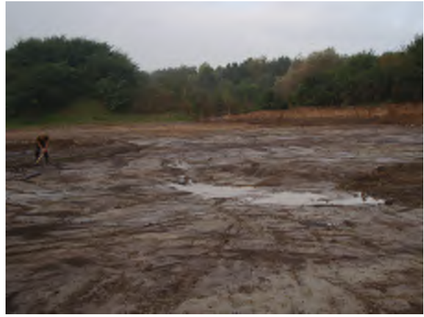
Foto 2: Het oppervlak in de voorgrond is het oorspronkelijke maaiveld na verwijdering van 1 meter recyclinggranulaat .
