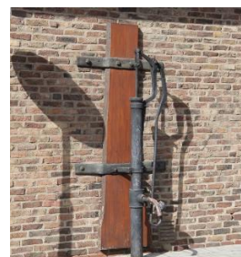
Waterpomp Berg a/d Maas
