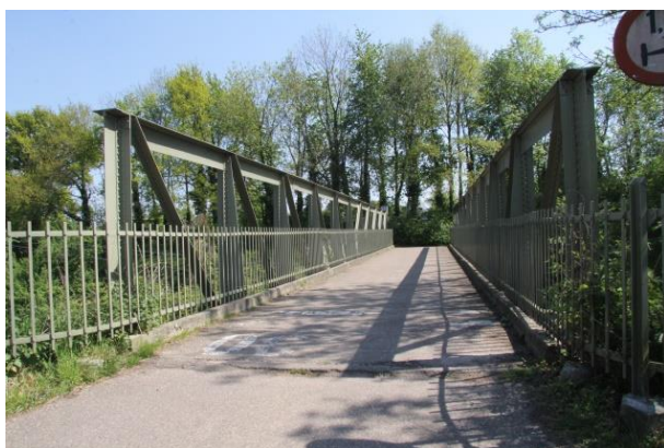
Spoorbrug bij Terhagen te Elsloo
