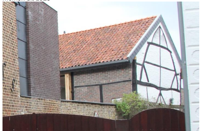
Vakwerk schuur (<1800) achter Raadhuisstraat 19 te Elsloo
