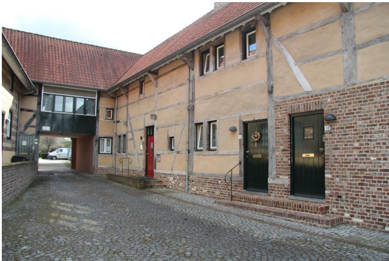
Afb. 61 gerestaureerde vakwerk deel I van de boerderij (rijksmonument) aan de Kerkstraat 16 te Berg a/d Maas
