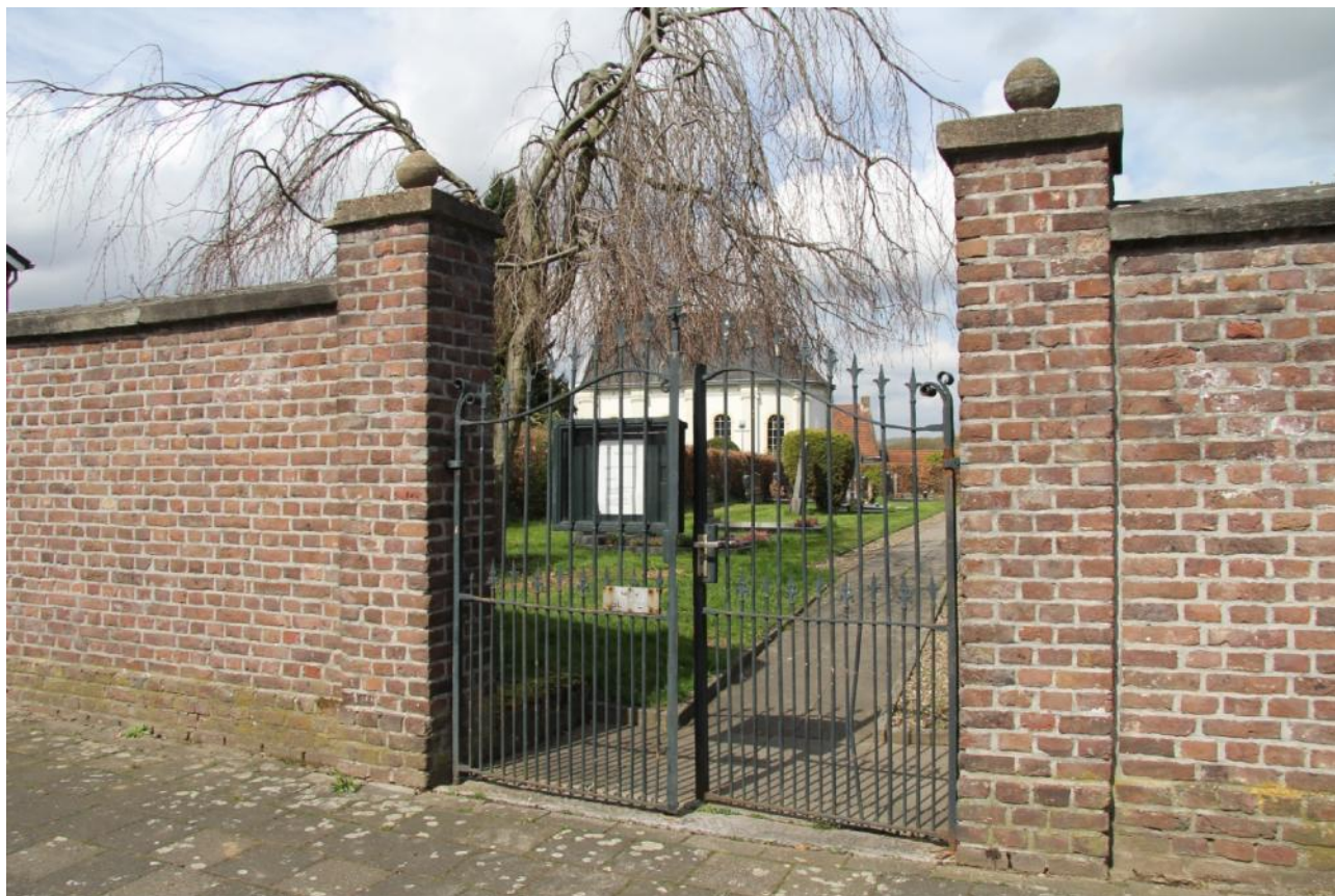
Afb. 58 Afscheidingsmuur en poort van de hervormde begraafplaats in Urmond
