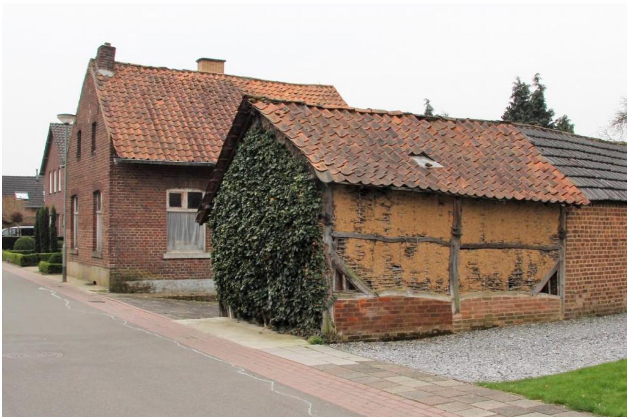
Afb. 51 Vakwerkschuurtje met leemvullingen aan de Nieuwstraat te Stein
