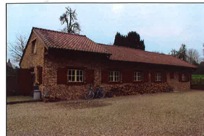
De westgevel van het gebouw, gezien vanuit de binnenhof
