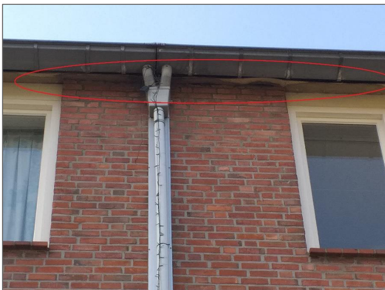
Figuur 3.1 Open dakrand bij Tripstraat en Kamperstraat.
