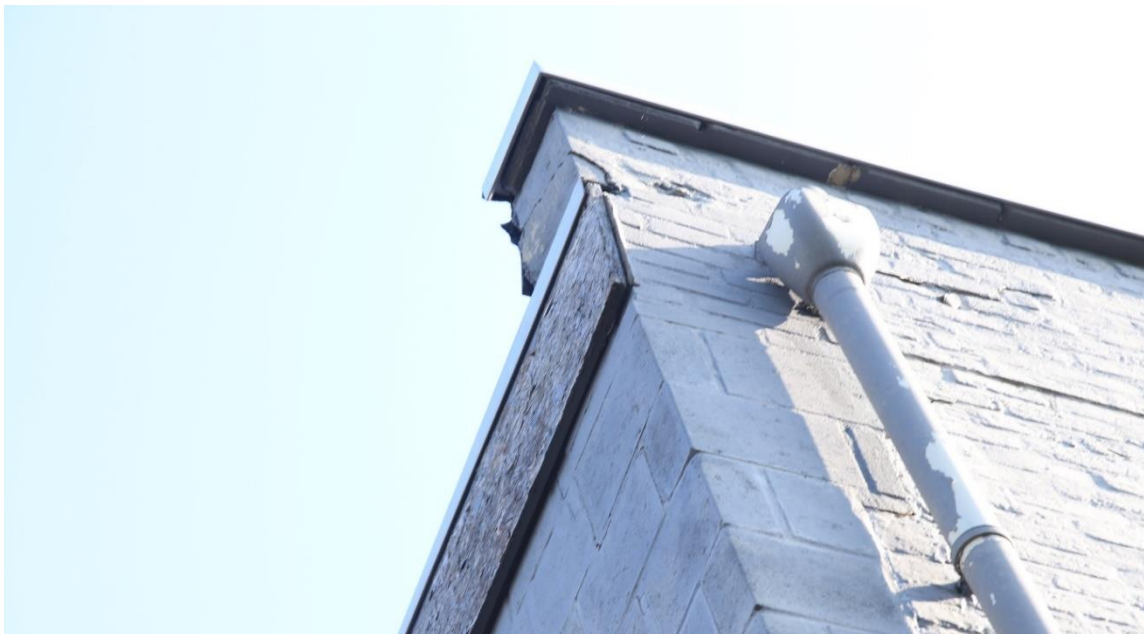
Foto 2: Zijkant van de meubelzaak, de daktrimmen zijn strak gemonteerd
