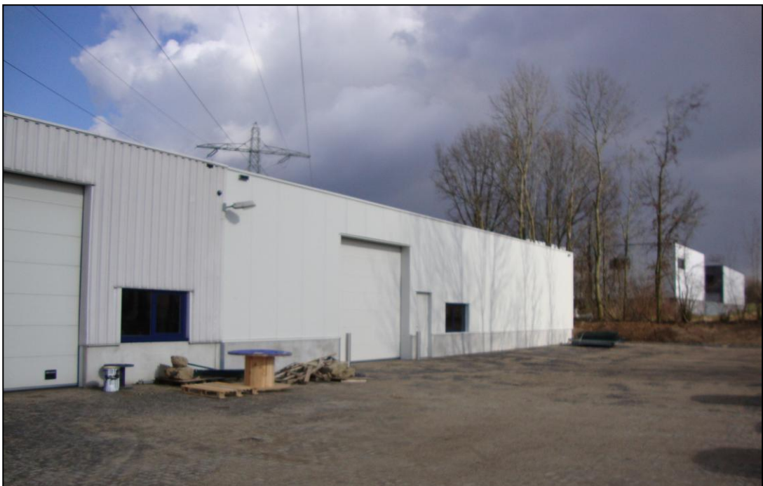
De zuidzijde van het bedrijfspand, met aan de oostzijde (op de foto rechts) de nieuwe loods
