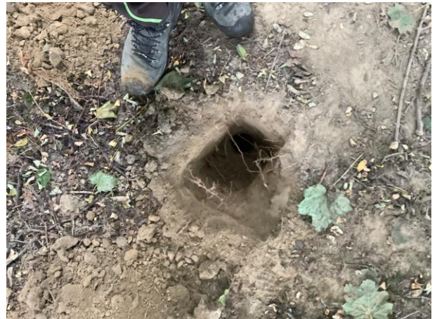
Foto 8 Inspectiegat met boring (boring 03)
