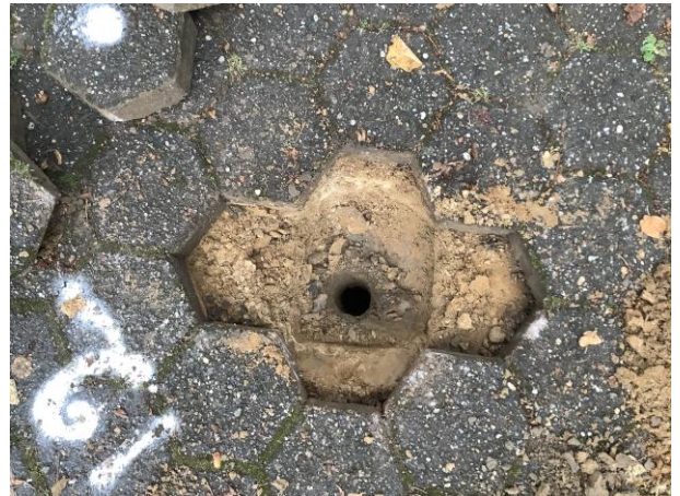
Foto 10 Inspectiegat met boring (boring 12)
