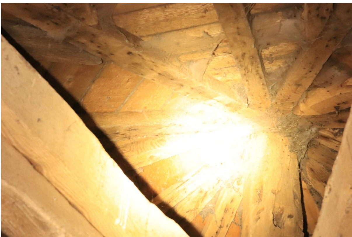
Foto 6: Ook de aanwezigheid van spinnenrag (hier op de zolder van de toren) vormt voor vleermuizen geen geschikte verblijfplaats
