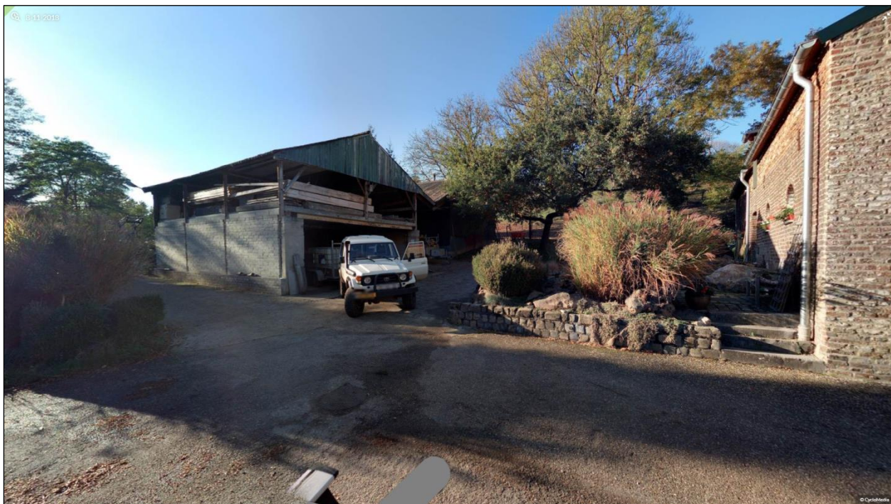
figuur 3: Aanzicht carréboerderij en bestaande schuur (Cyclomedia)
