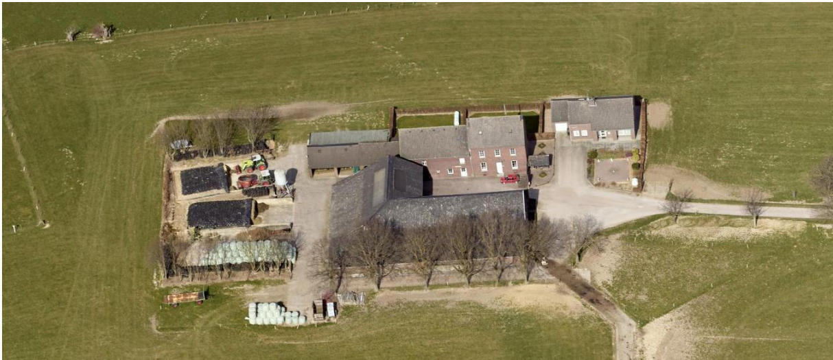
Afbeelding 2. Luchtfoto huidige situatie plangebied
