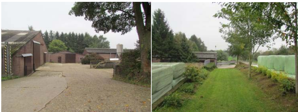
Zicht op de hoofdontsluiting (links) en zicht op de nevenontsluiting, met links de sleufsilos
