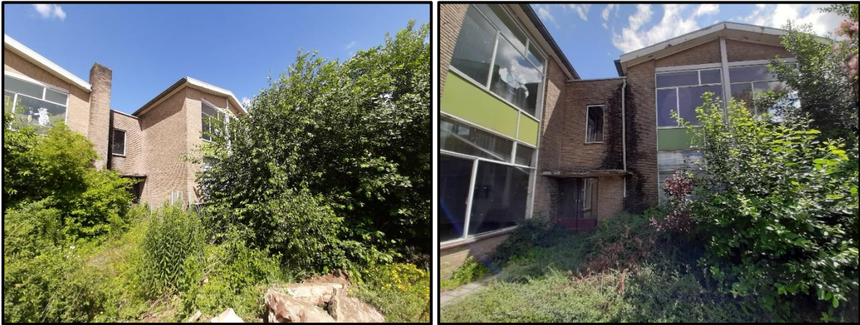
Figuur 1.3 Situatie van het “oude” schoolgebouw.
